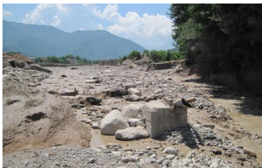
ب) تخریب کامل ایستگاه هیدرومتری رامیان
