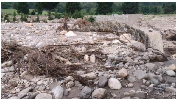
ب) پر شدن مخزن سد انحرافی از رسوبات
