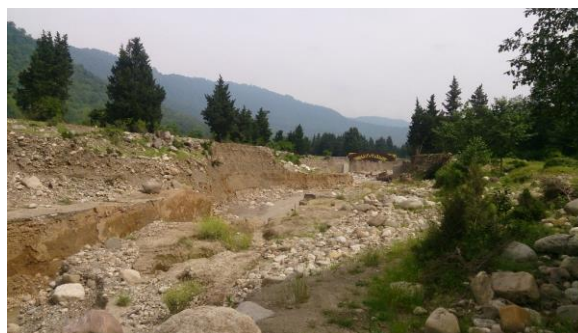
الف) آبشستگی شدید در پایین دست رودخانه در طول زیاد
