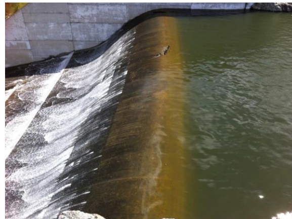
شکل ۱- سرریز اوجی و ویژگی‌های هندسی سرریز مورد بررسی توسط مهندسان ارتش آمریکا [۱۳].
